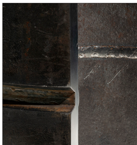
MIG SRS - Prima passata su tubo con cianfrino
